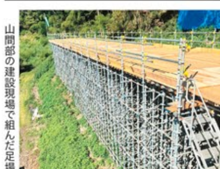
山間部の建設現場で組んだ足場
