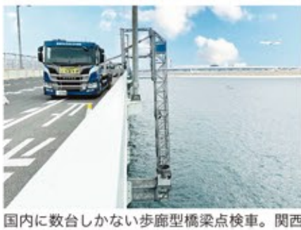
国内に数台しかない歩廊型橋梁点検車。関西国際空港連絡橋の点検業務の様子
