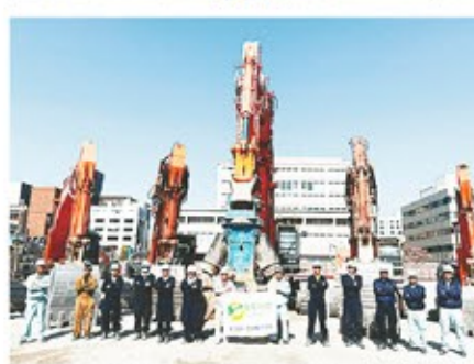
昨年、解体工事を終えた岡島百貨店跡地
