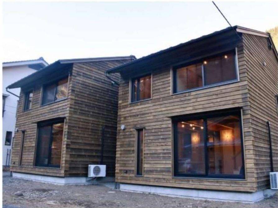
完成した「モバイル建築」住宅 丹波山村
