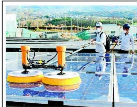
【写真上】気泡水でパネルを洗浄する担当者【写真下】洗浄に使用するパブル発生機と揚水ポンプ(手前) 〓いずれも甲府市下向山町
