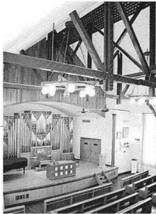
キングポスト・トラス構造の吹き抜けが特徴的なグリーンバンク・チャペル—いずれも甲府市愛宕町
