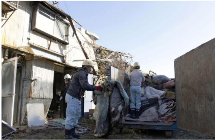
略式代執行により解体工事が始まった空き家 二甲府市内
