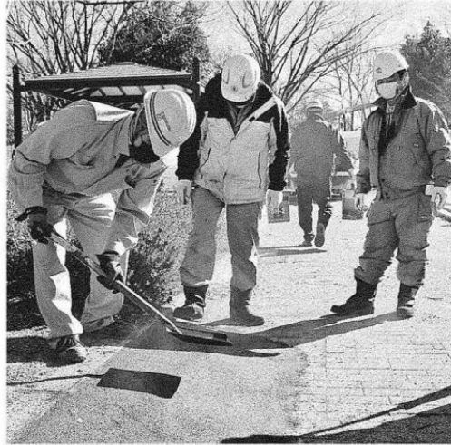
広場と歩道の段差を埋める作業員 || 南アルプス・御勅使南公園
